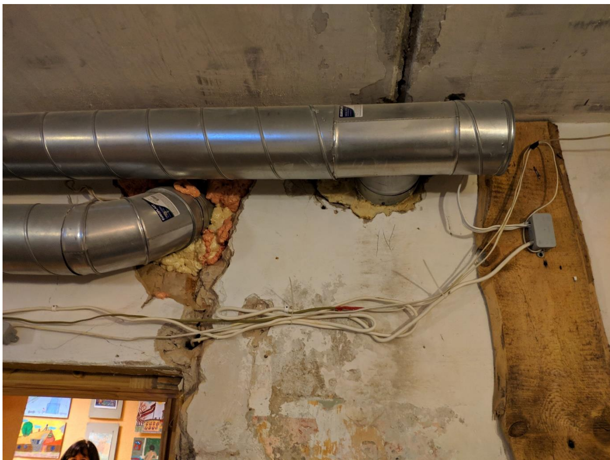
Attēls nr.7 Nedroša elektroinstalācija un sienu apdares bojājumi
