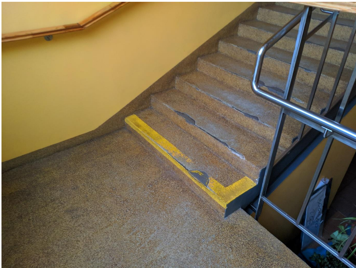
Attēls nr.23 Kāpņu pakāpienu virsmas apdare nolietojusies.
