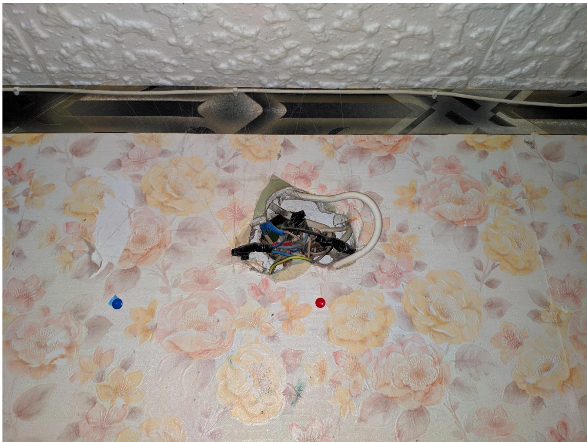
Attēls nr.5 Nedroša elektroinstalācija (1.stāvs)
