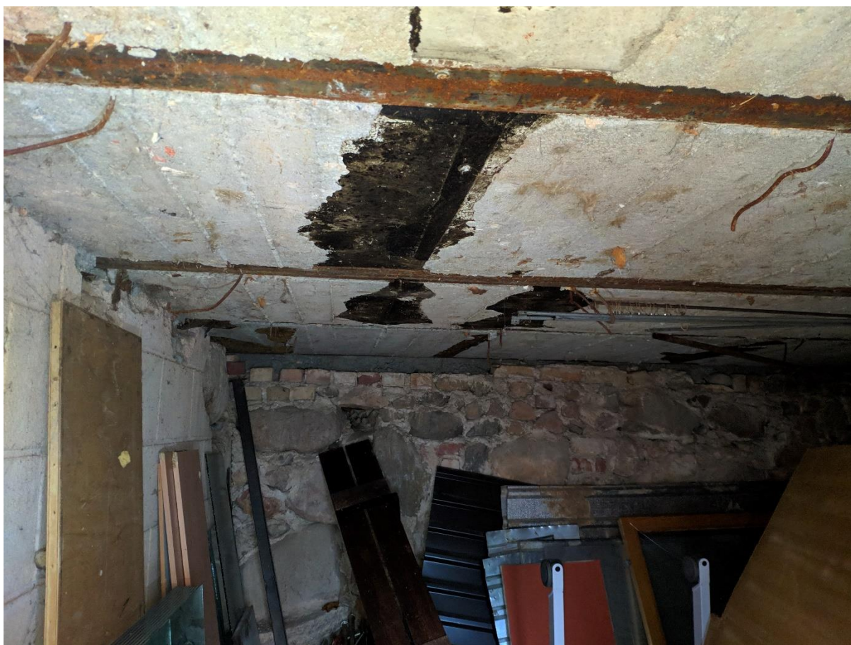
Attēls nr.22 Tērauda sija virspusēja korozija
