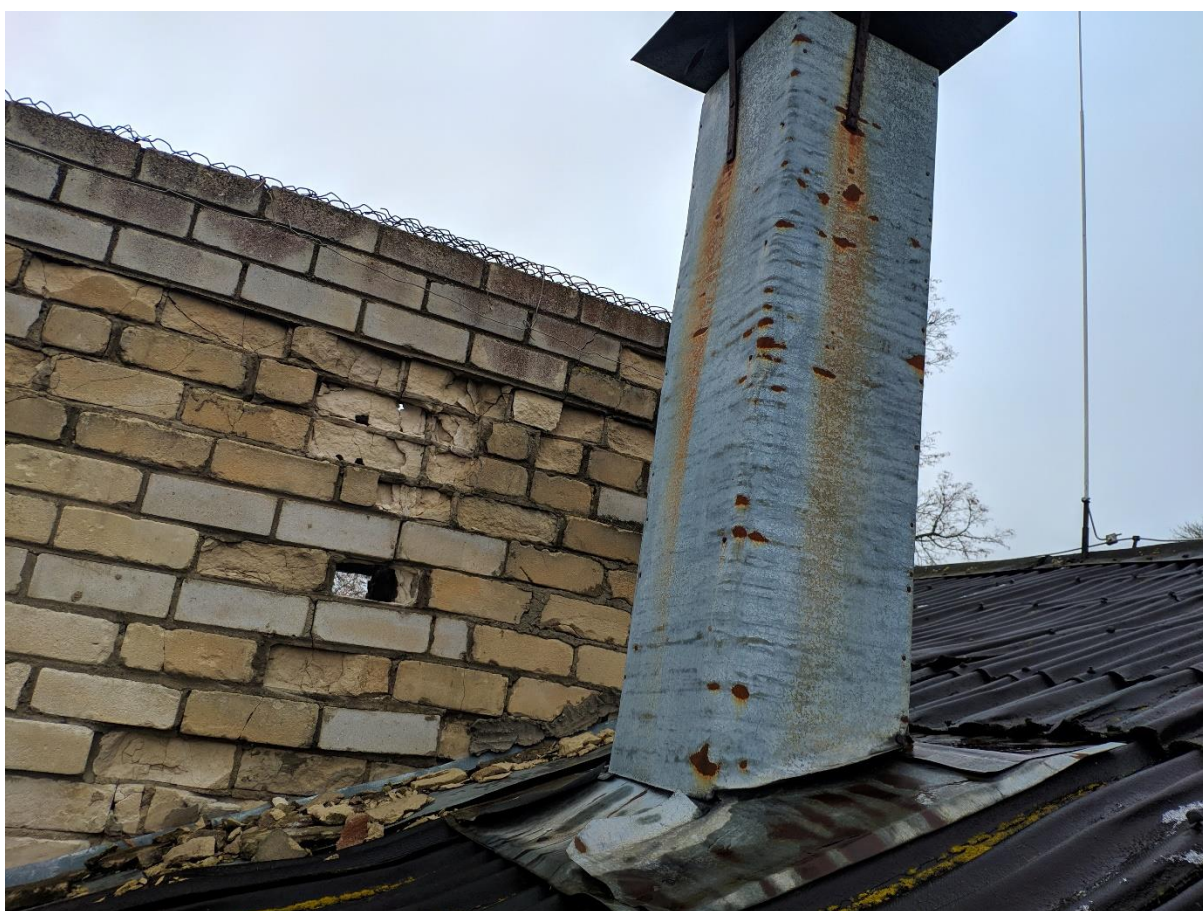
Attēls nr.22 Mūra ventilācijas kanāla mūrējuma erozija
