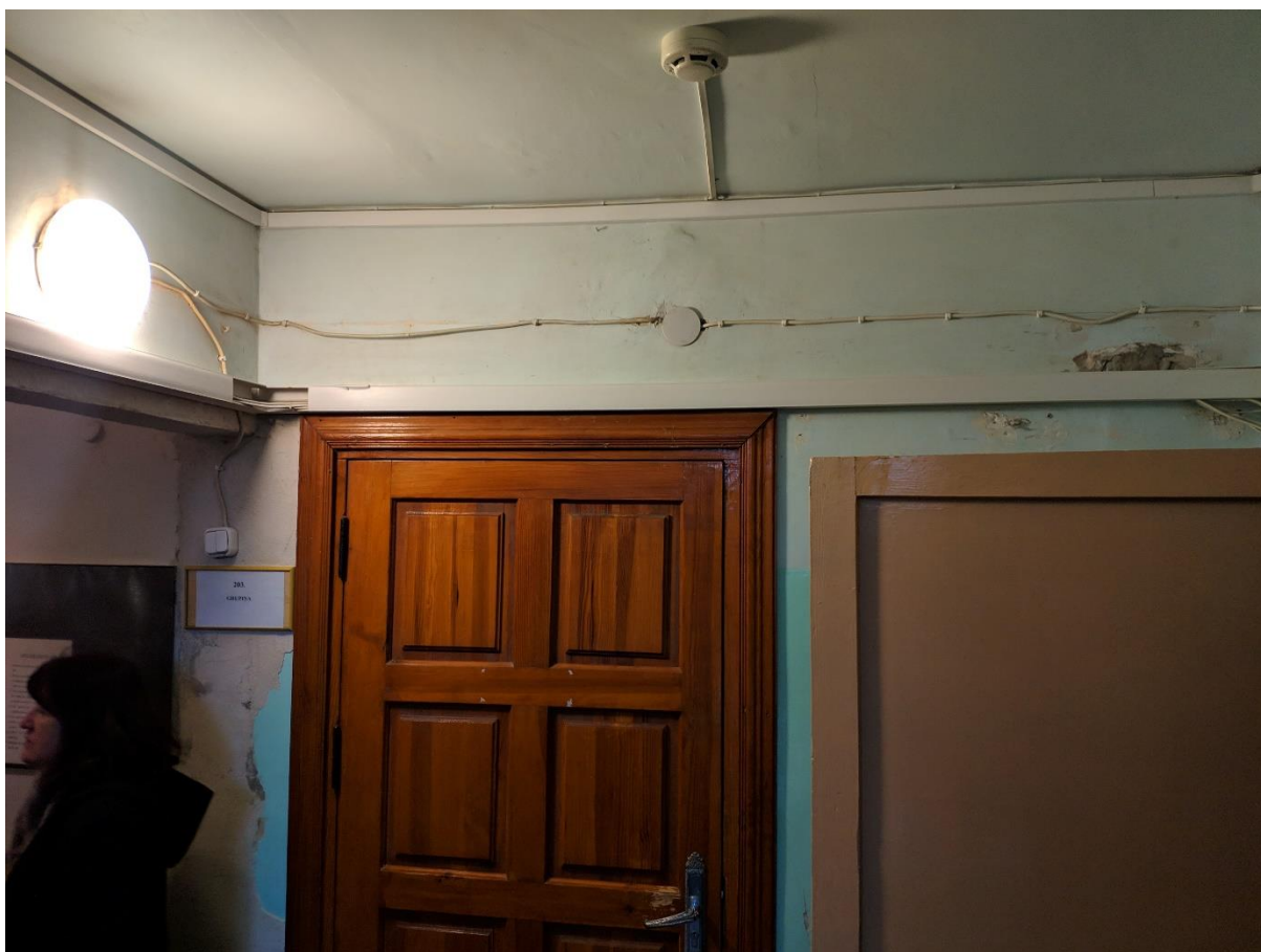
Attēls nr.16 Kāpņu telpas durvis bez durvju pašizvēršanās mehānismiem
