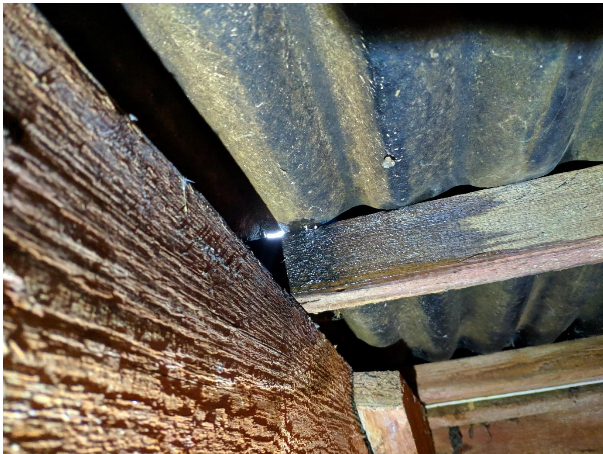
Attēls nr.19 Jumta seguma bojājumi (caurumi) un mitruma piesūcināta koka lata.
