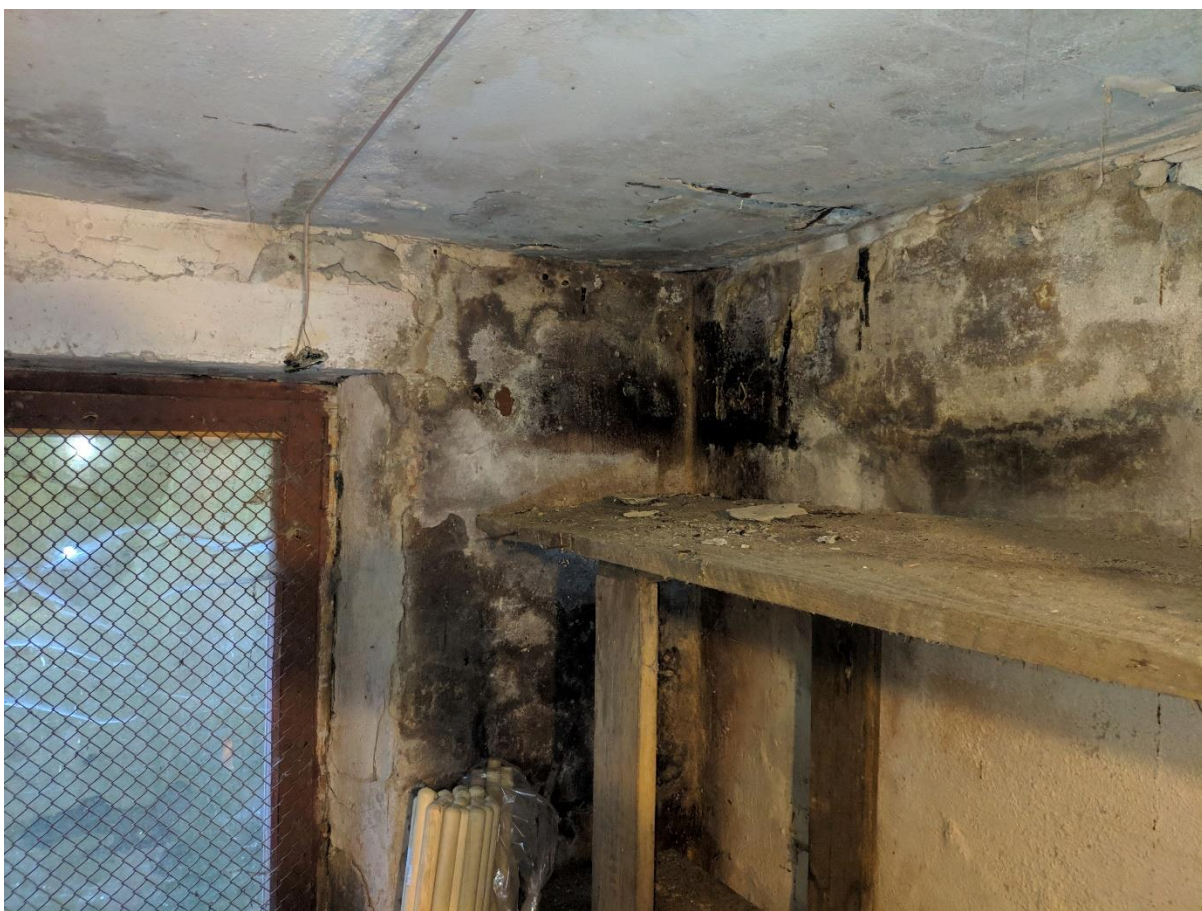
Attēls nr.6 Mitruma radīti bojājumi (-1.st telpa nr.77)
