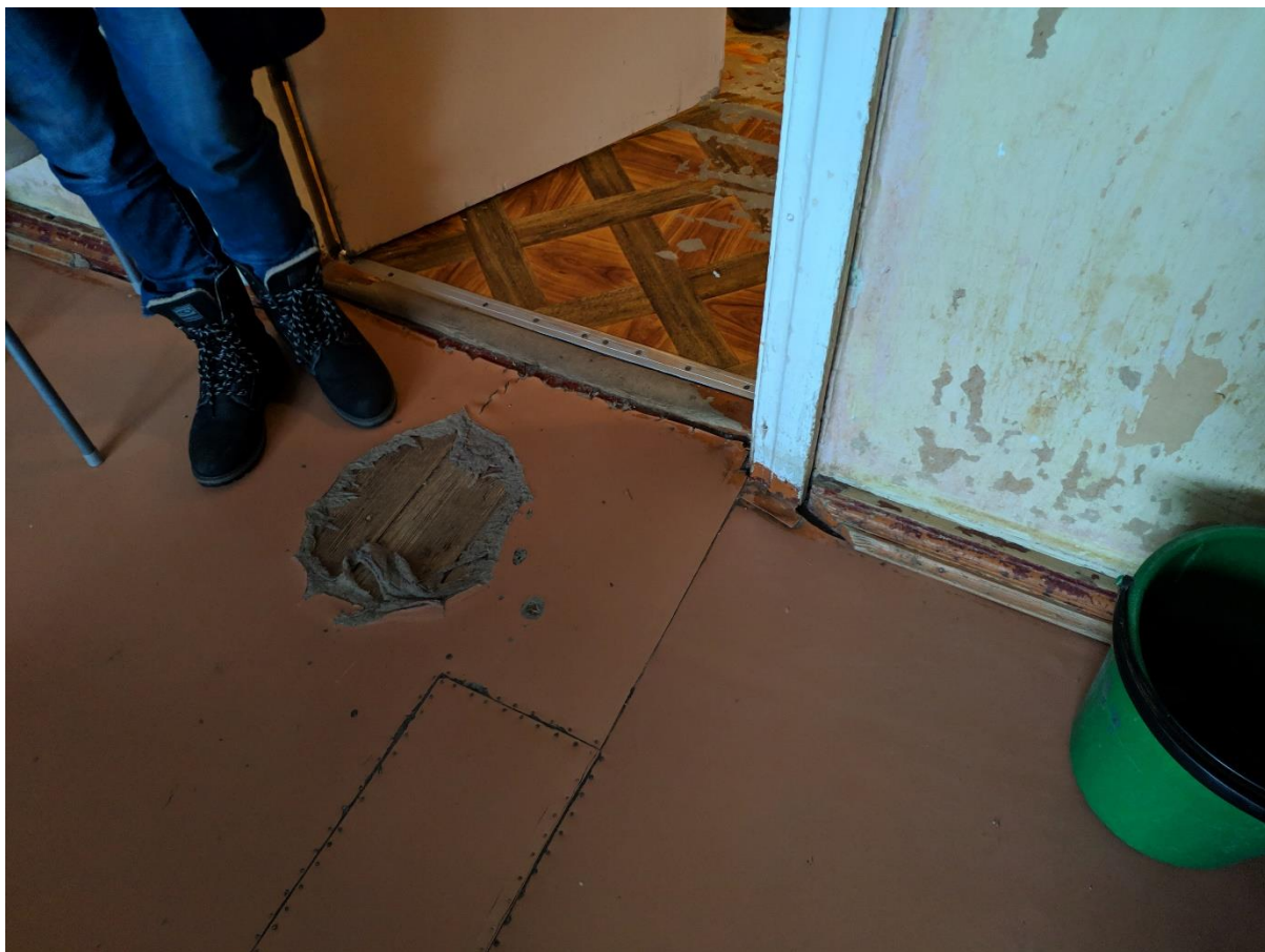
Attēls nr.14 Sienu apdares un grīdas seguma bojājumi
