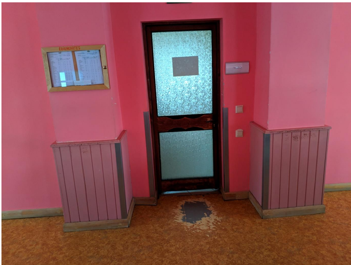
Attēls nr.1 Grīdas seguma izdiluums (Pirmā stāva ēdamzāle)
