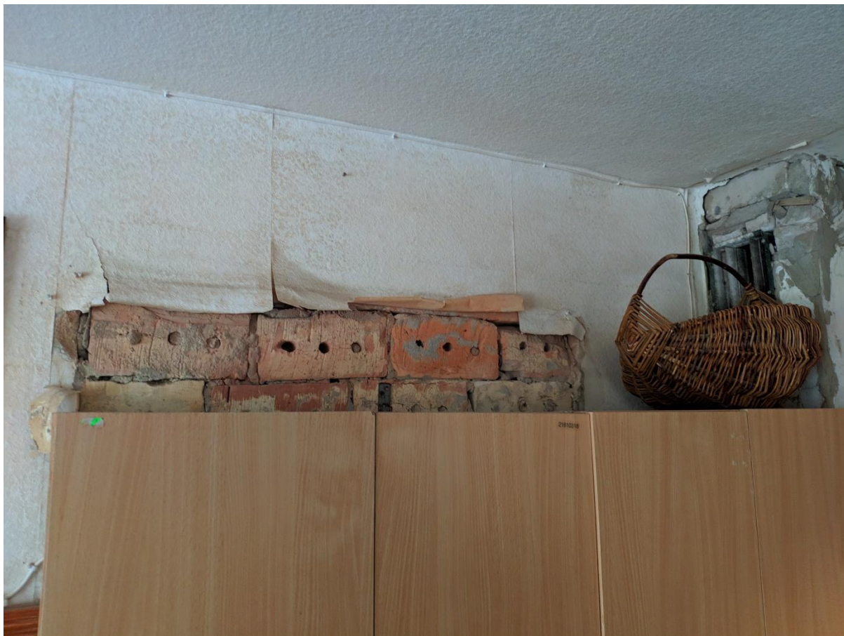
Attēls nr.15 Aizmūrēta durvju aile bez apdares
