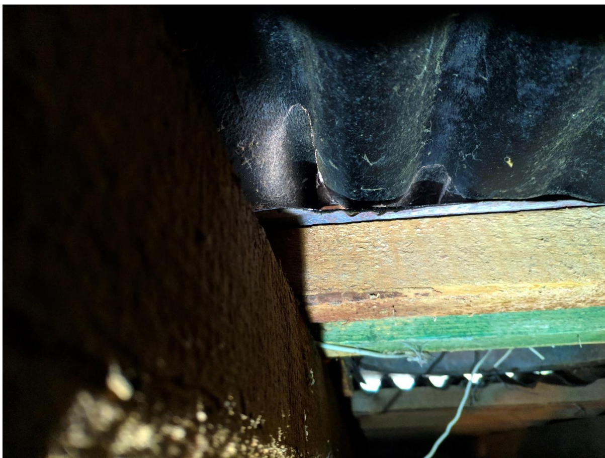
Attēls nr.18 Jumta seguma bojājumi(caurumi)
