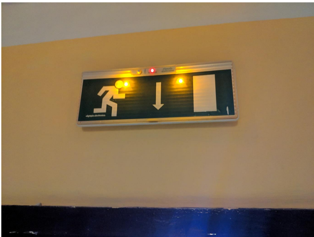
Attēls nr.12 Evakuācijas gaismekļi, kuriem nokalpojuši akumulatori (2.st un 3.st
