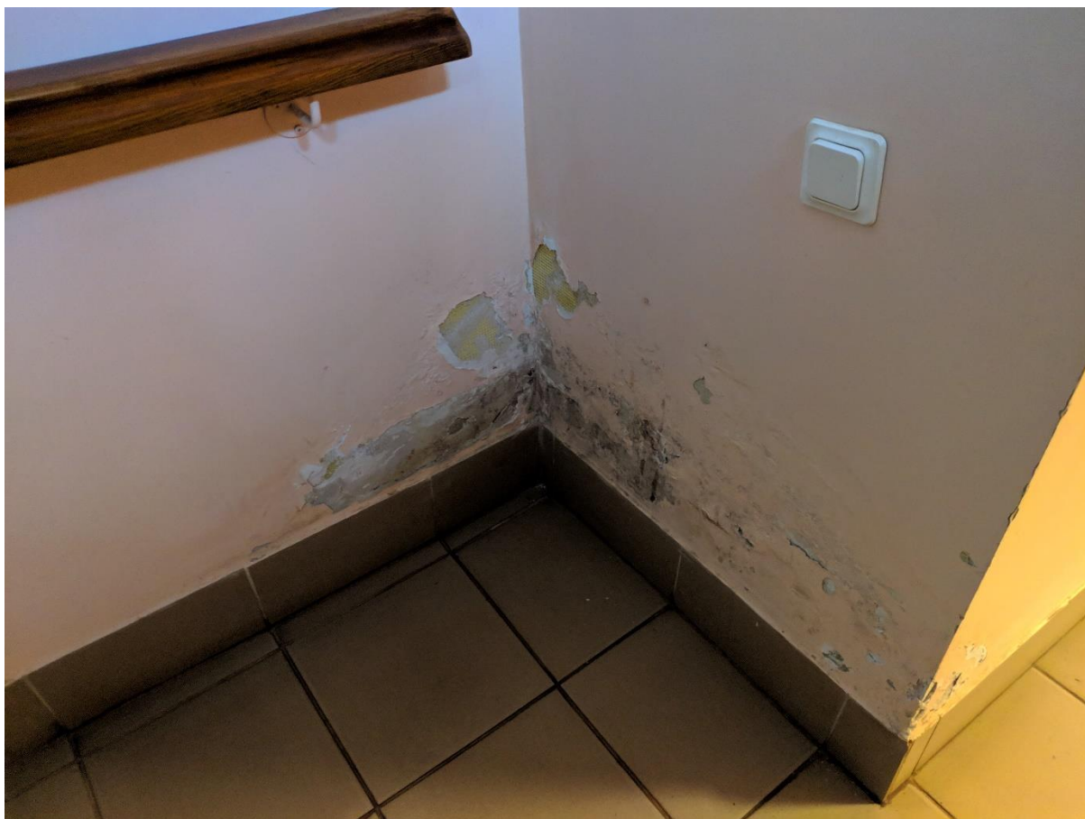
Attēls nr.23 Mitruma radīti sienu apdares bojājumi
