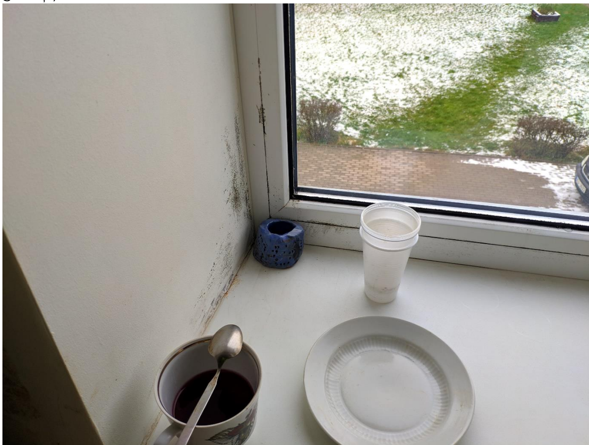
Attēls nr.13 Kondensāta radīti logu ailes apdaes bojājumi
