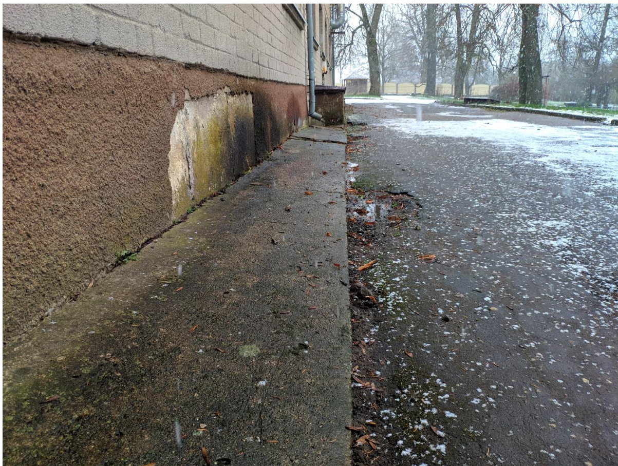
Attēls nr.27 Betona ēkas aizsargapmale ar slīpumu uz ēkas pusi
