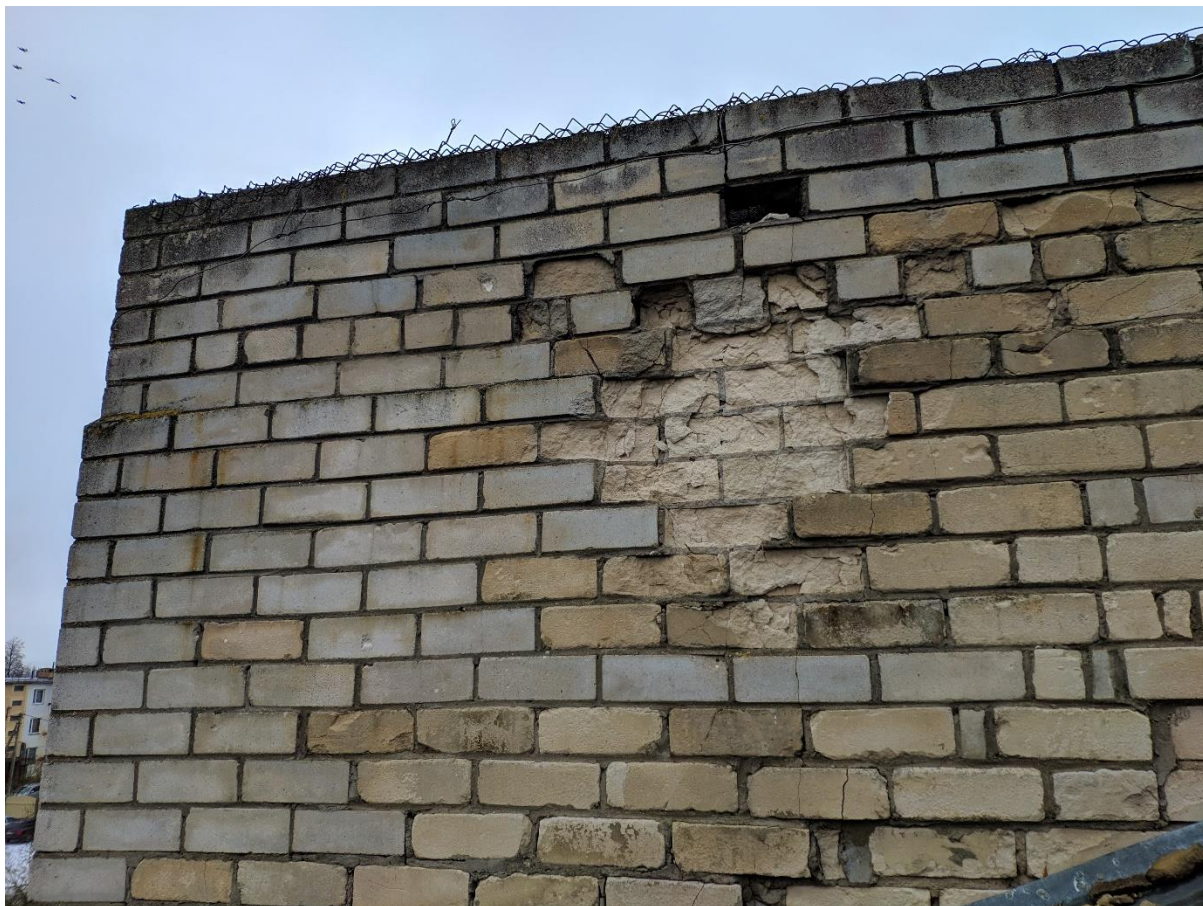
Attēls nr.21 Mūra ventilācijas kanāla mūrējuma erozija
