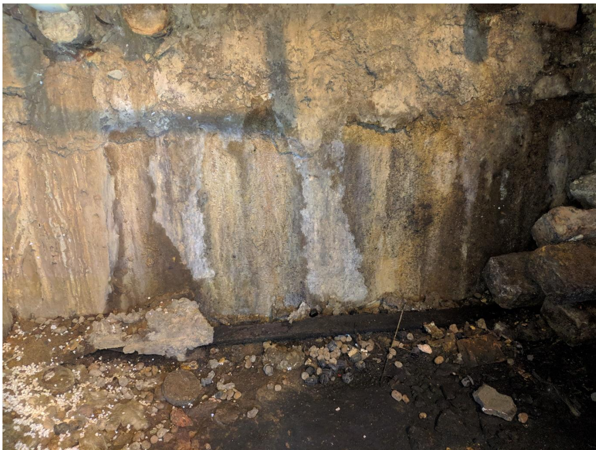
Attēls nr.11 Mitruma iekļūšana ēkā (-1 stāvs)
