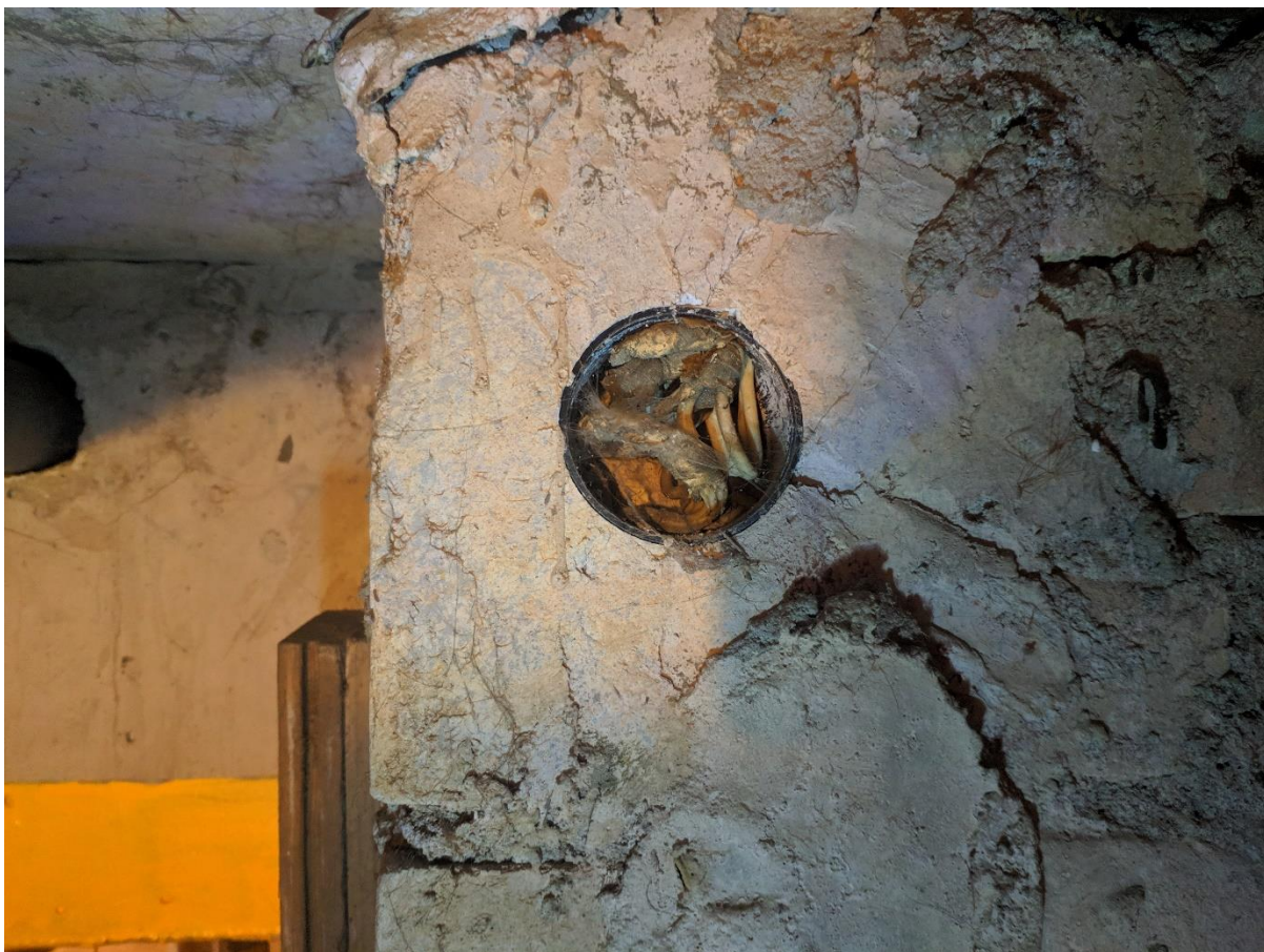
Attēls nr.10 Nedroša elektroinstalācija. Savienojumu kārbām trūkst nosegvāks
