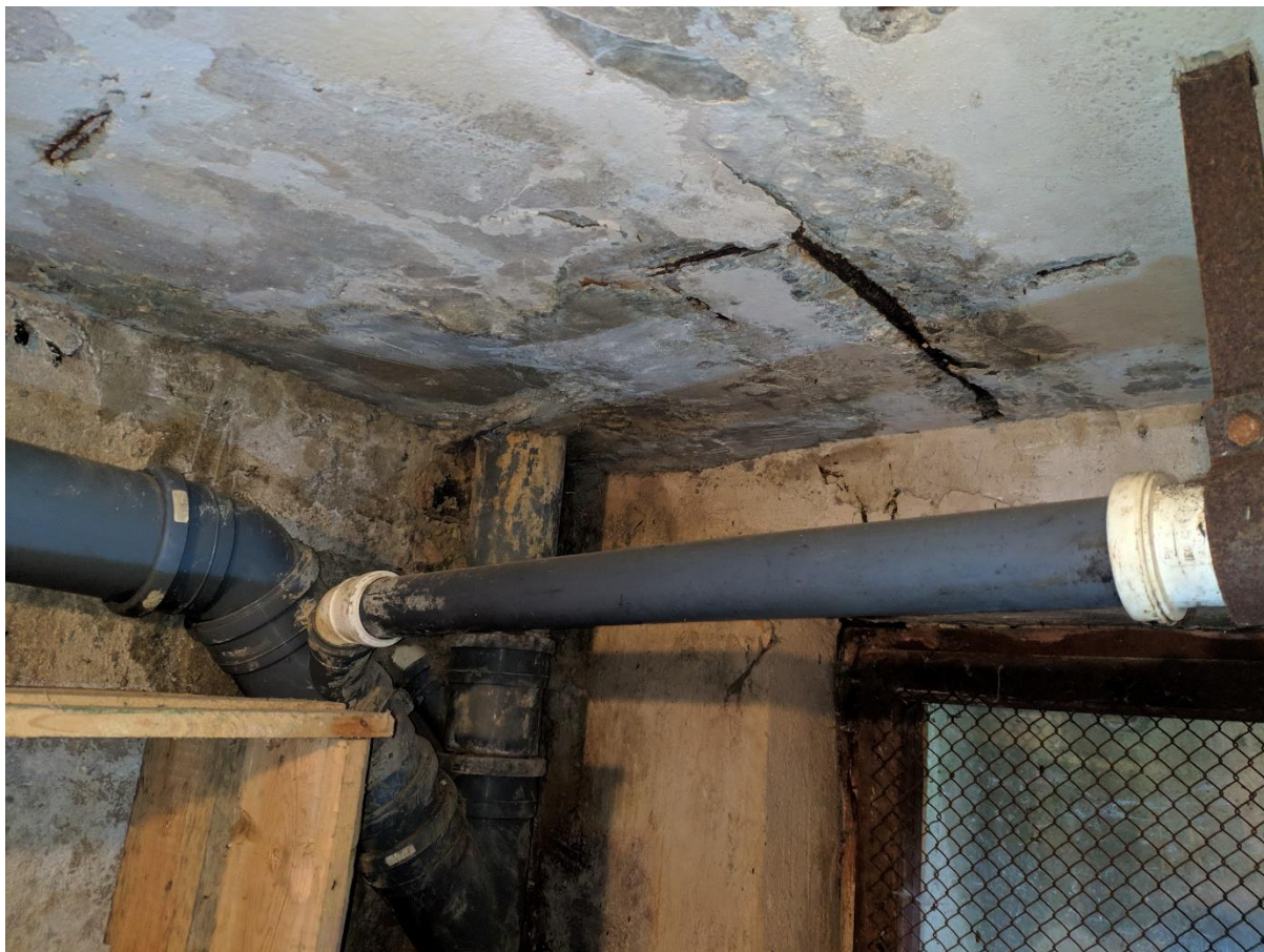
Attēls nr.7 Mitruma radīti bojājumi (-1 stāvs telpa nr.77)
