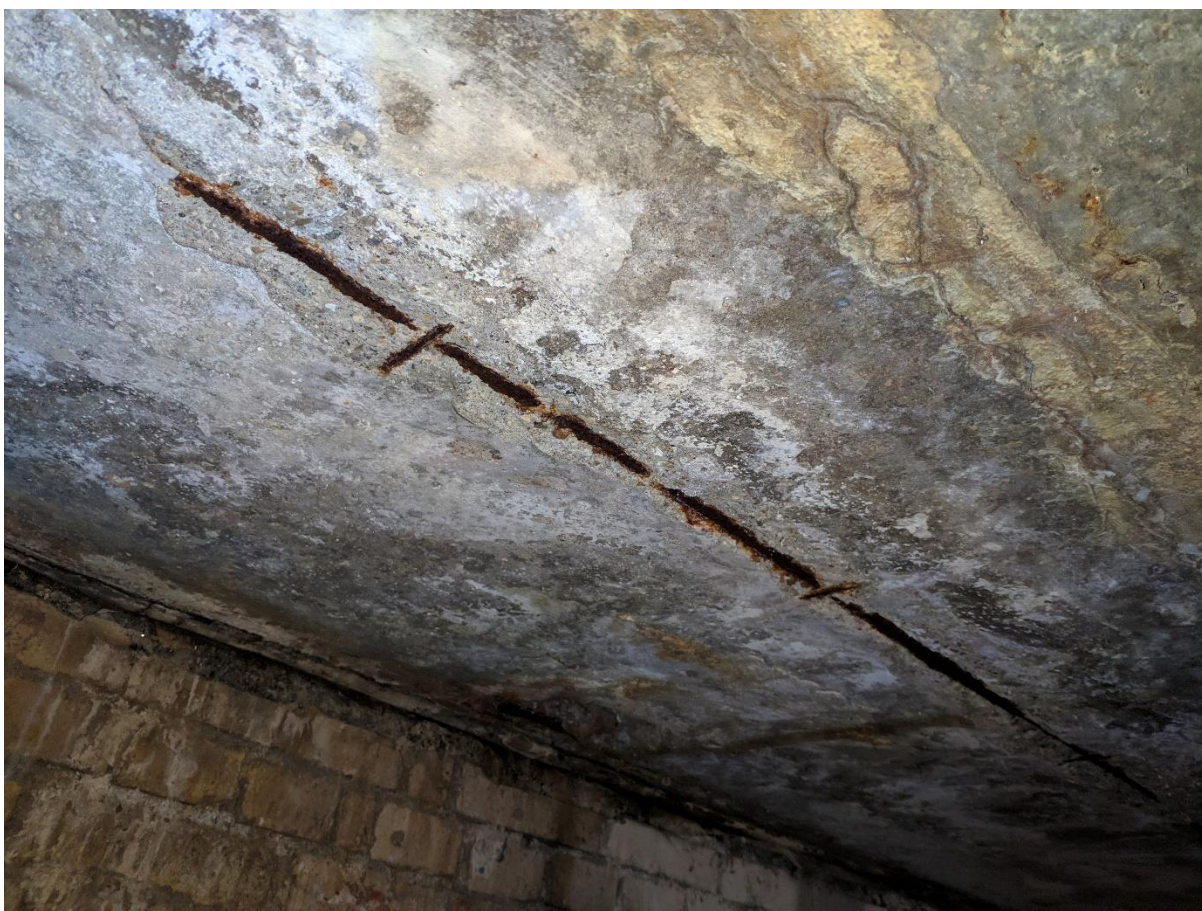
Attēls nr.4 Dzelzsbetona panelim bojāta betona aizsargkārtā
